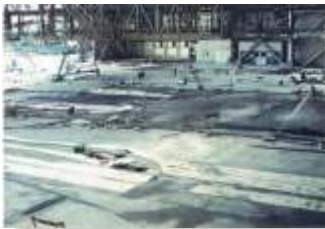
東京羽田国際空港 日本航空ジャンボ第一機体工場 地盤沈下復旧工事 セボンド&TBK材料&リトリン
