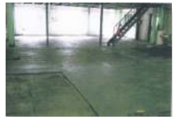
兵庫T社明石工場 常に重量物を運ぶ10tトラックが出入り セボンド&TBK材料&リトリン (写真提供:東亜貿易)
