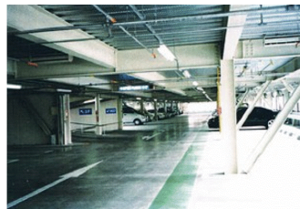
JR守山駅前駐車場工事 (写真提供:東亜貿易)
