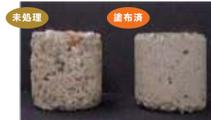
※緻密になることでコンクリート表面の劣化状態の違いがはっきりと現れた。
