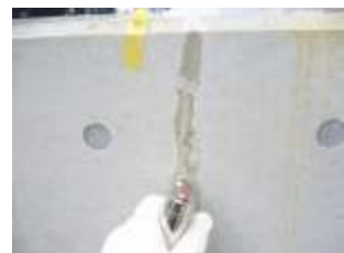
低圧注入工法 (ひび割れ幅:0.20mm)
