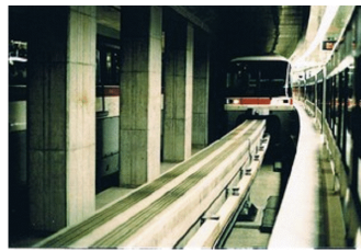
東京モルレルー羽田・羽田空港間 PCコンクリート軌道工事 (写真提供:東亜貿易)
