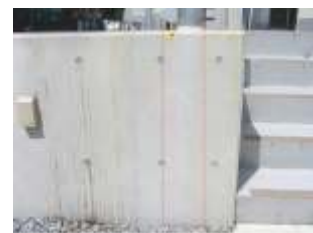
施工完了 (目止め材撤去)
